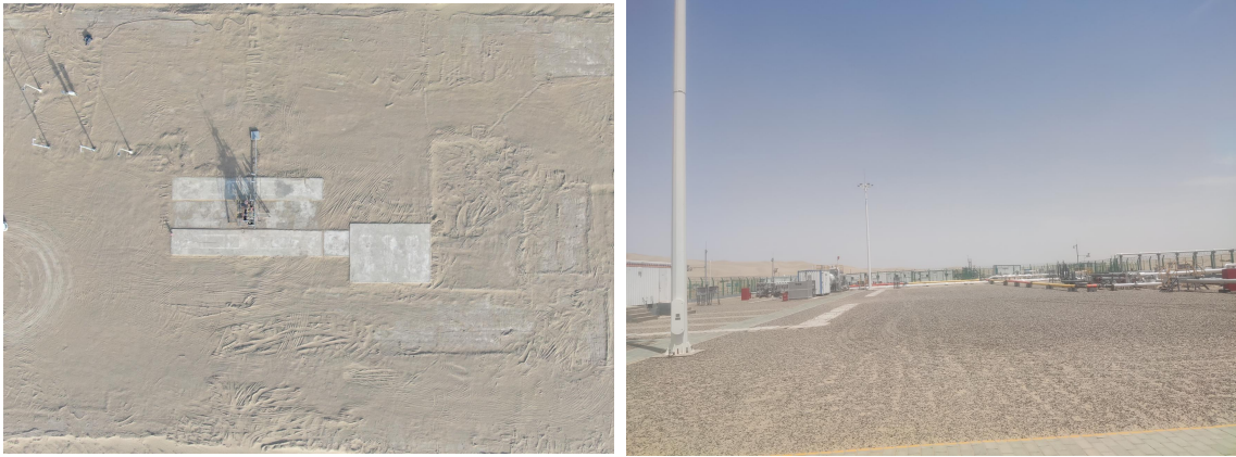
图 3.1-1 玉科区块现有井场情况
